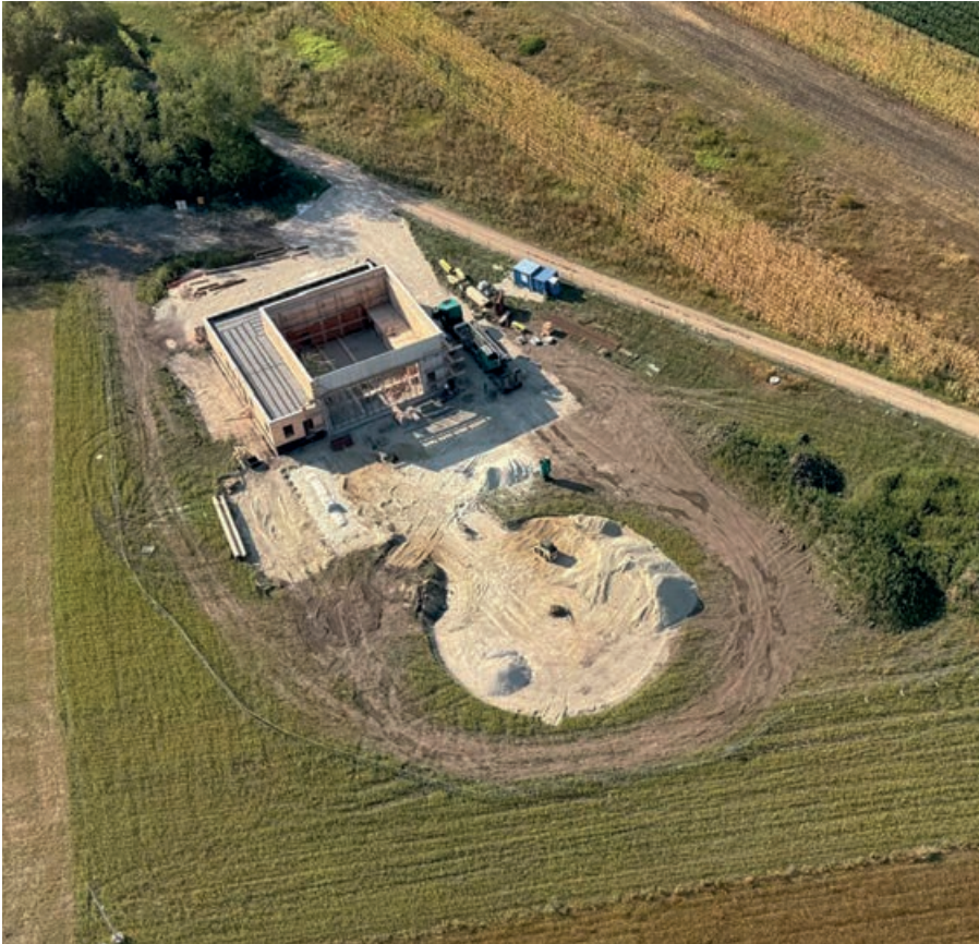
Schon im Rohbau lässt sich das Ausmaß des neuen Stützpunktes erahnen.
