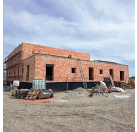
Die Arbeiten sind in noch vollem Gange.
